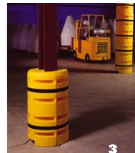
1,2. De Mobile EasyKey beperkt wie er met de truck kan rijden en kan d.m.v. bepaalde opties gepersonaliseerd worden. (Foto met dank aan MobileEasykey/Crepa) www.mobileeasykey.com 3. Column Sentry beschermers absorberen de schok in geval van een botsing, wat leidt tot minder schade aan gebouwen en trucks. (Foto met dank aan Sentry®/Crepa) www.sentrypro.com
